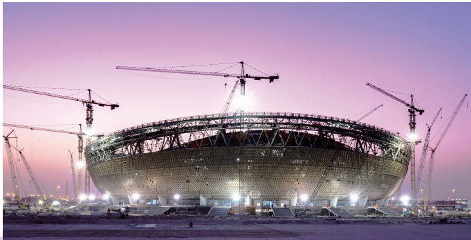
公司塔机助力卡塔尔 2022 世界杯主场馆建设。任杰 供图
