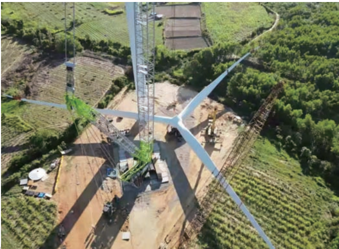
ZCC9800W 履带式起重机正在进行风电扇叶吊装作业。
