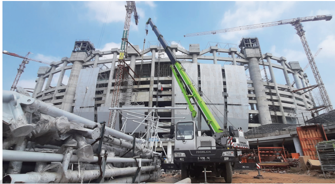
中联重科设备在雅加达国际体育场施工。
