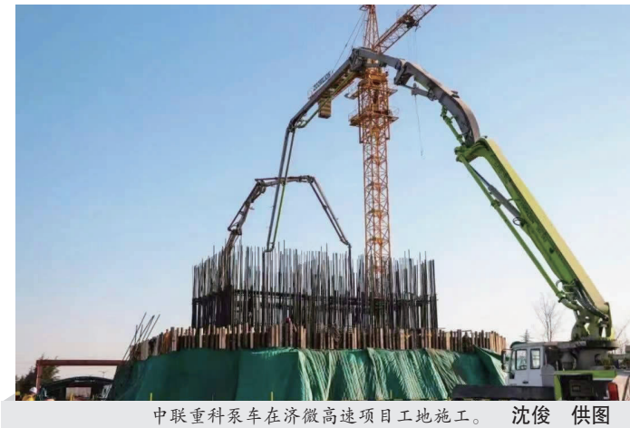
中联重科泵车在济微高速项目工地施工。 沈俊 供图
