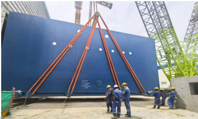
中联重科履带起重机助力海南昌江核电 3 号机组凝汽器壳体吊装。杨牧意 供图
