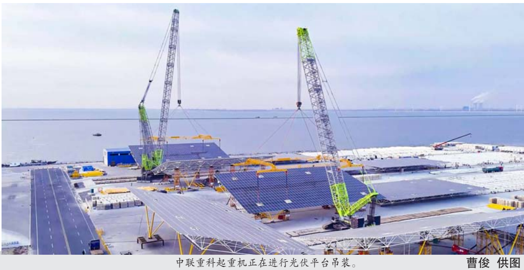
中联重科起重机正在进行光伏平台吊装。
