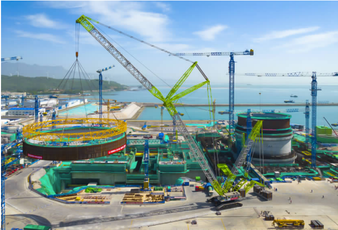
中联重科 2000 吨履带起重机正在吊装 3 号机组钢衬里模块六。 (图片来源于网络公众号“中核国电漳州能源有限公司”)
