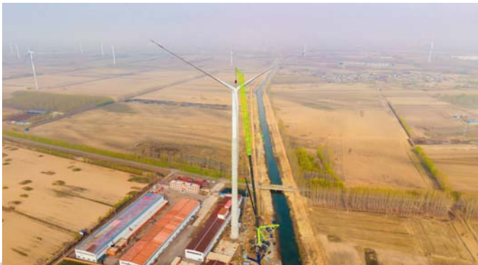
全球最大吨位全地面起重机 ZAT40000H7 正在辽宁鞍山市台安县风电机组安装现场作业。 郭赞 供图
