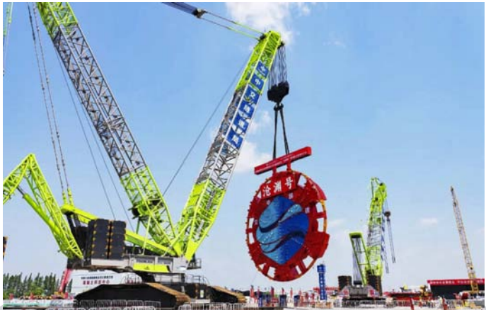
中联重科履带起重机吊装国内最大直径盾构机刀盘。杨牧意 供图
