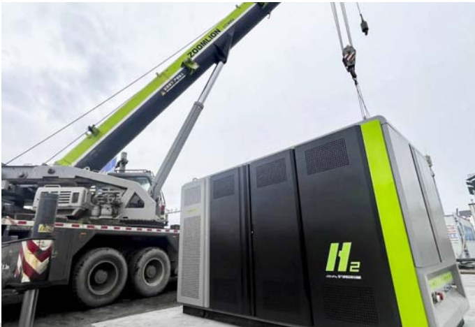
中联重科撬装加氢站包头安装现场。 李家宇 供图
