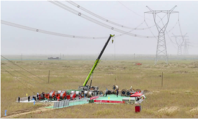
项目最后一段电线架设现场。李家宇 供图
